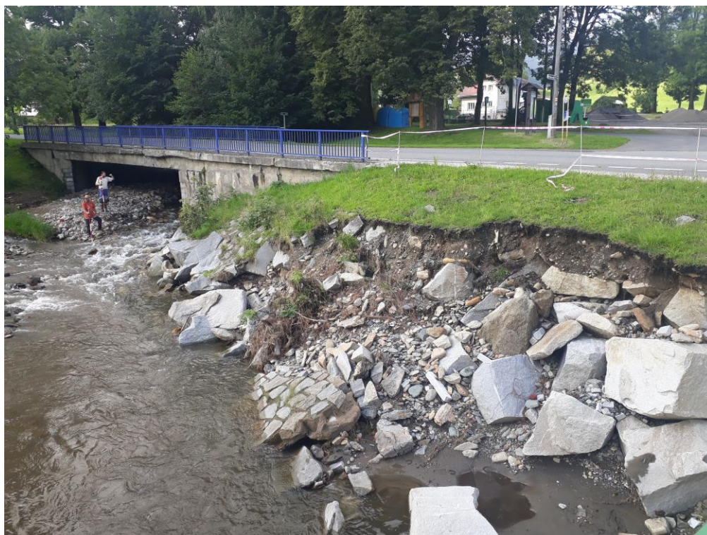
Foto 4 Poškozené opevnění a nátrž na LB
