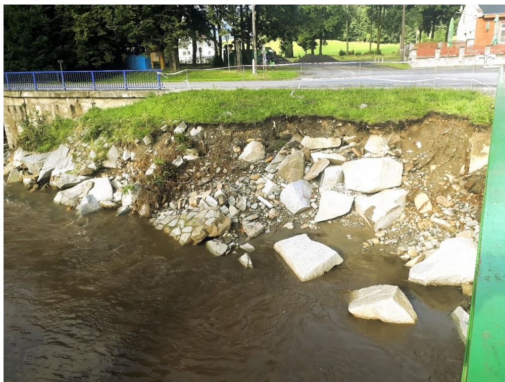
Foto 3 Poškozené opevnění a nátrý na LB
